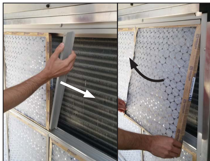
Figura 22 - Retirada dos filtros
