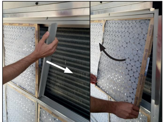
Figura 22 - Retirada dos filtros
