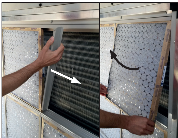
Figura 26 - Retirada dos filtros
