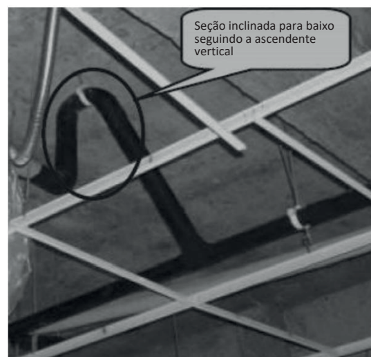
Figura 3-6.7: Seção inclinada para baixo da tubulação de drenagem
