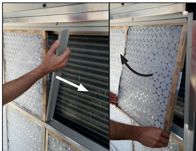
Figura 19 - Retirada dos filtros
