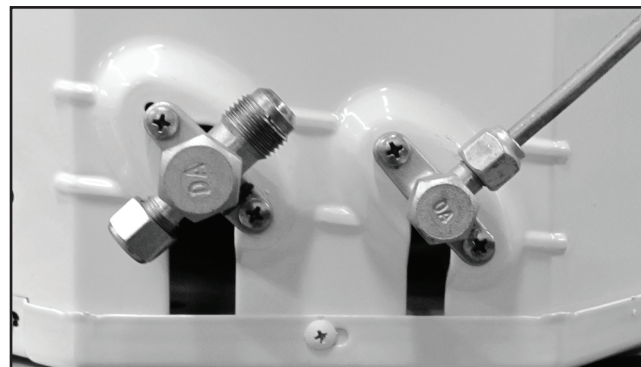
FIG. 33 - CONEXÃO LINHA DE EXPANSÃO UN. CONDENSADORA
