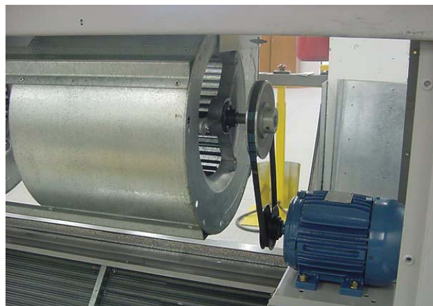
Figura 11 - Motor do Ventilador
