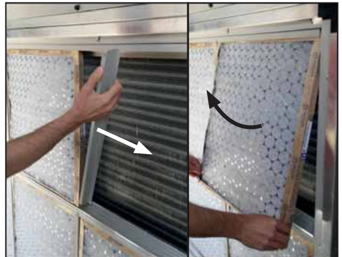
Figura 22 - Retirada dos filtros
