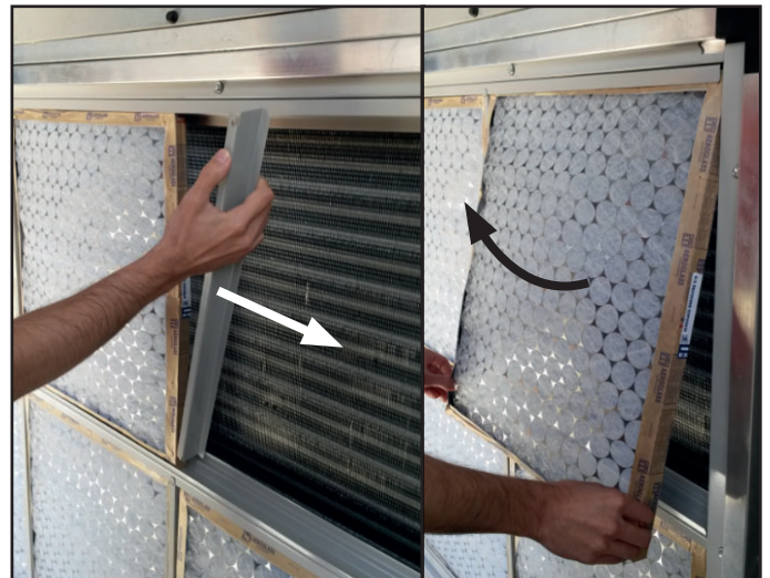
Figura 22 - Retirada dos filtros
