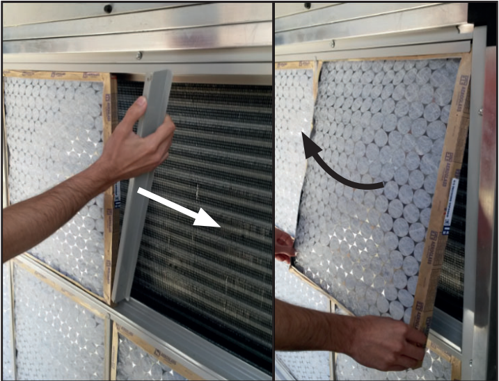
Figura 26 - Retirada dos filtros
