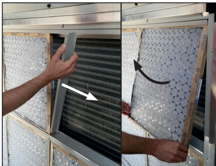
Figura 26 - Retirada dos filtros
