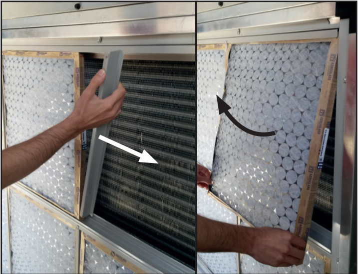
Figura 26 - Retirada dos filtros
