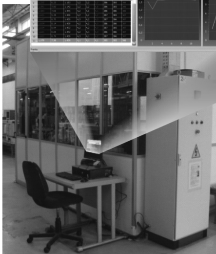
Teste de fábrica (Run-test)
