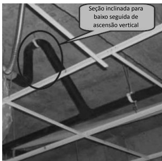
Figura 3-6.7: Seção inclinada descendente da tubulação de drenagem
