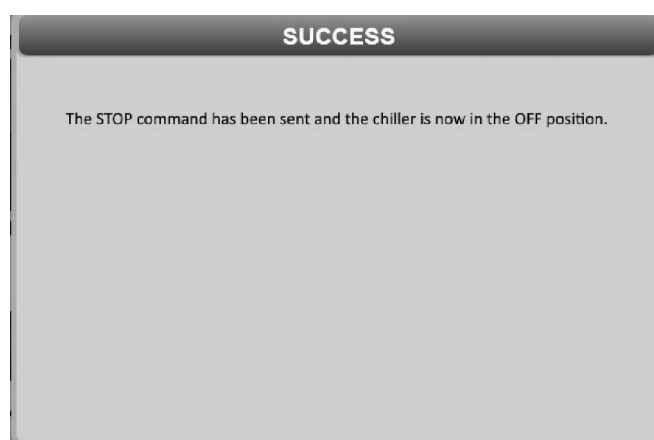
Fig. 36 – Chiller na tela Posição Off (desligado)
