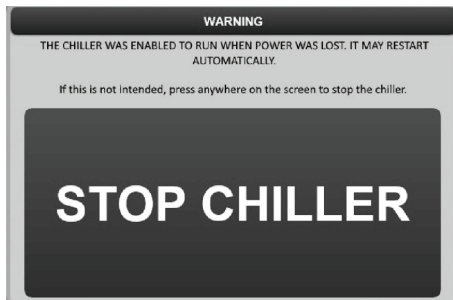
Fig. 35 – O chiller pode reiniciar automaticamente a tela de aviso
