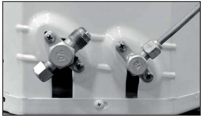
FIG. 41 - CONEXÃO DA LINHA DE EXPANSÃO DA UNIDADE CONDENSADORA
