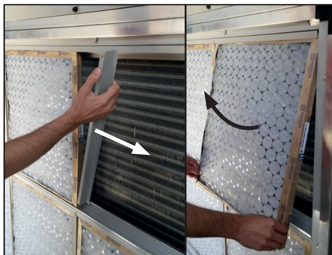
Figura 19 - Retirada dos filtros
