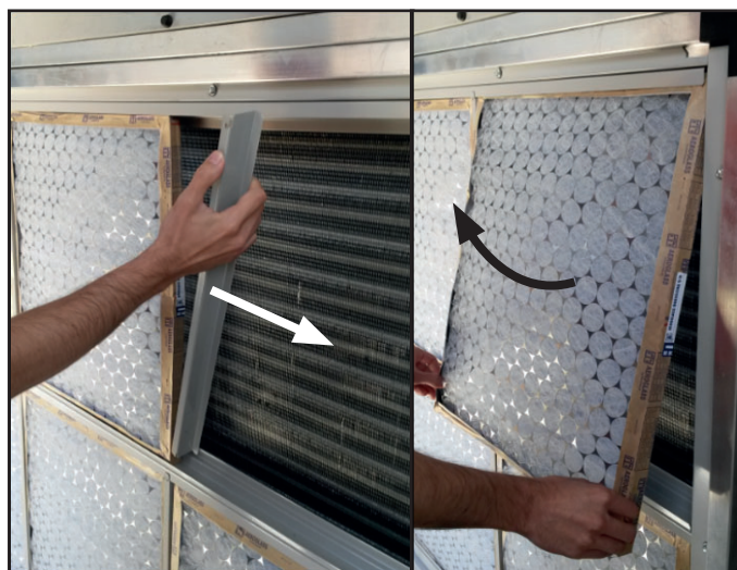
Figura 19 - Retirada dos filtros
